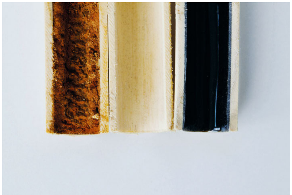
Bodenheizungsrohr: Vor, während und nach der Sanierung mit dem HAT-System.
