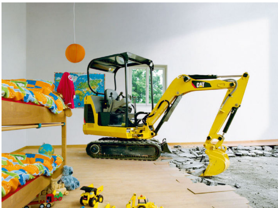
Solche Baustellen können Sie mit dem HAT-System verhindern.
