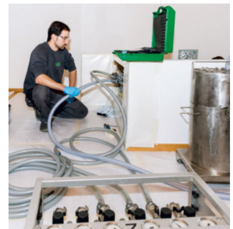
Sanierung mit dem Original: HAT-System.
