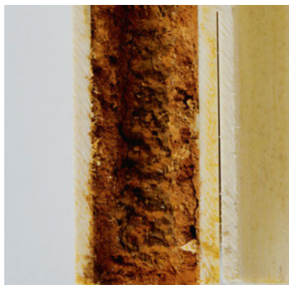
Bodenheizungsrohr: Vor, während und nach der Sanierung mit dem HAT-System.
