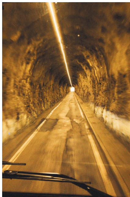
Sur le parcours, on emprunte un tunnel étroit, qui est à sens unique.
