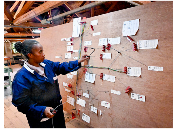
Volle Konzentration: Die Kabel für die Elektrik werden von Hand geflochten.
